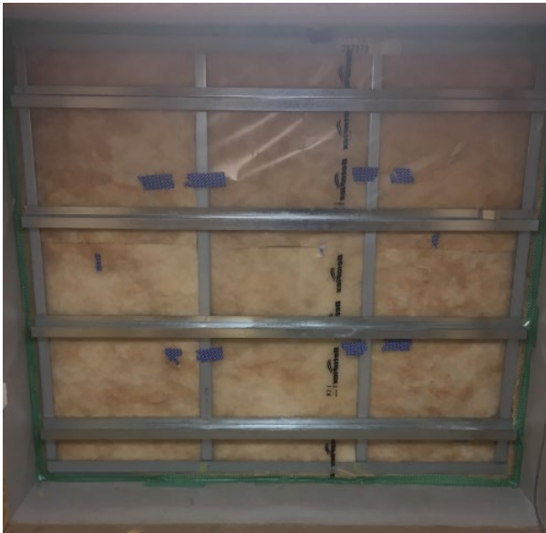
Foto 11 - Væg med krydsende lægter
