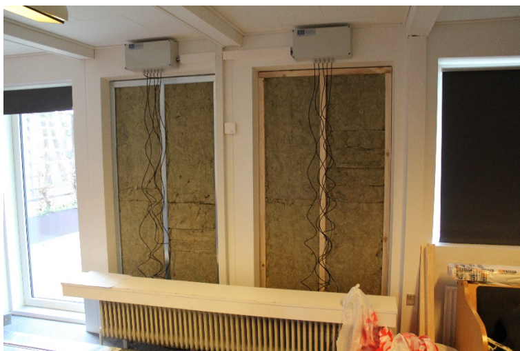
Foto 15 - Thermal Wall under opførelsen
