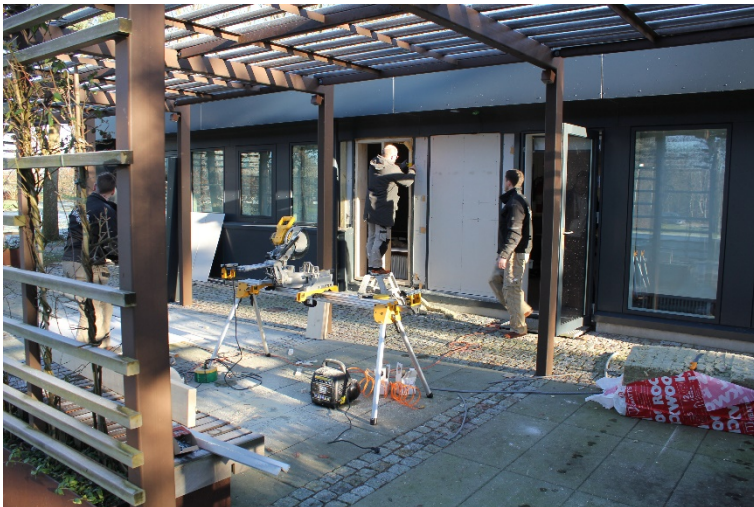
Foto 14 - Opbygning af Thermal Wall
