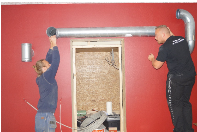
Foto 4 - 2 bygningskonstruktørstuderende monterer ventilationsanlægget 14. oktober 2016
