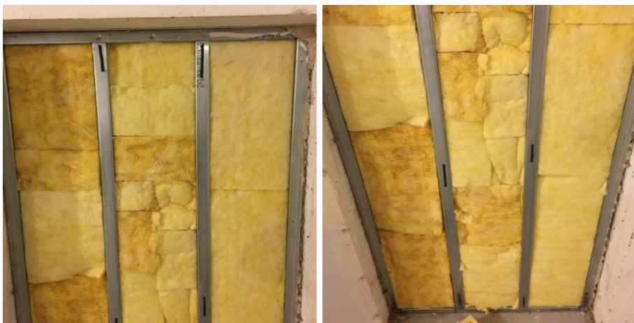
Foto 26 - Opsætning af testemne i døråbning
