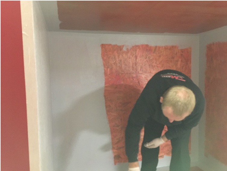
Foto 5 - Bygningskonstruktørstuderende udfører vådrumssikring 21. oktober 2016
