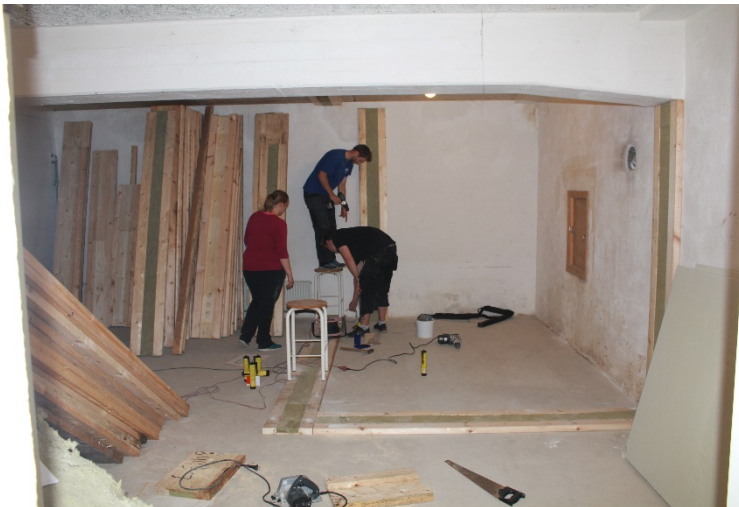
Foto 2 - Bygningskonstruktørstuderende påbegynder byggearbejdet 6. juni 2016
