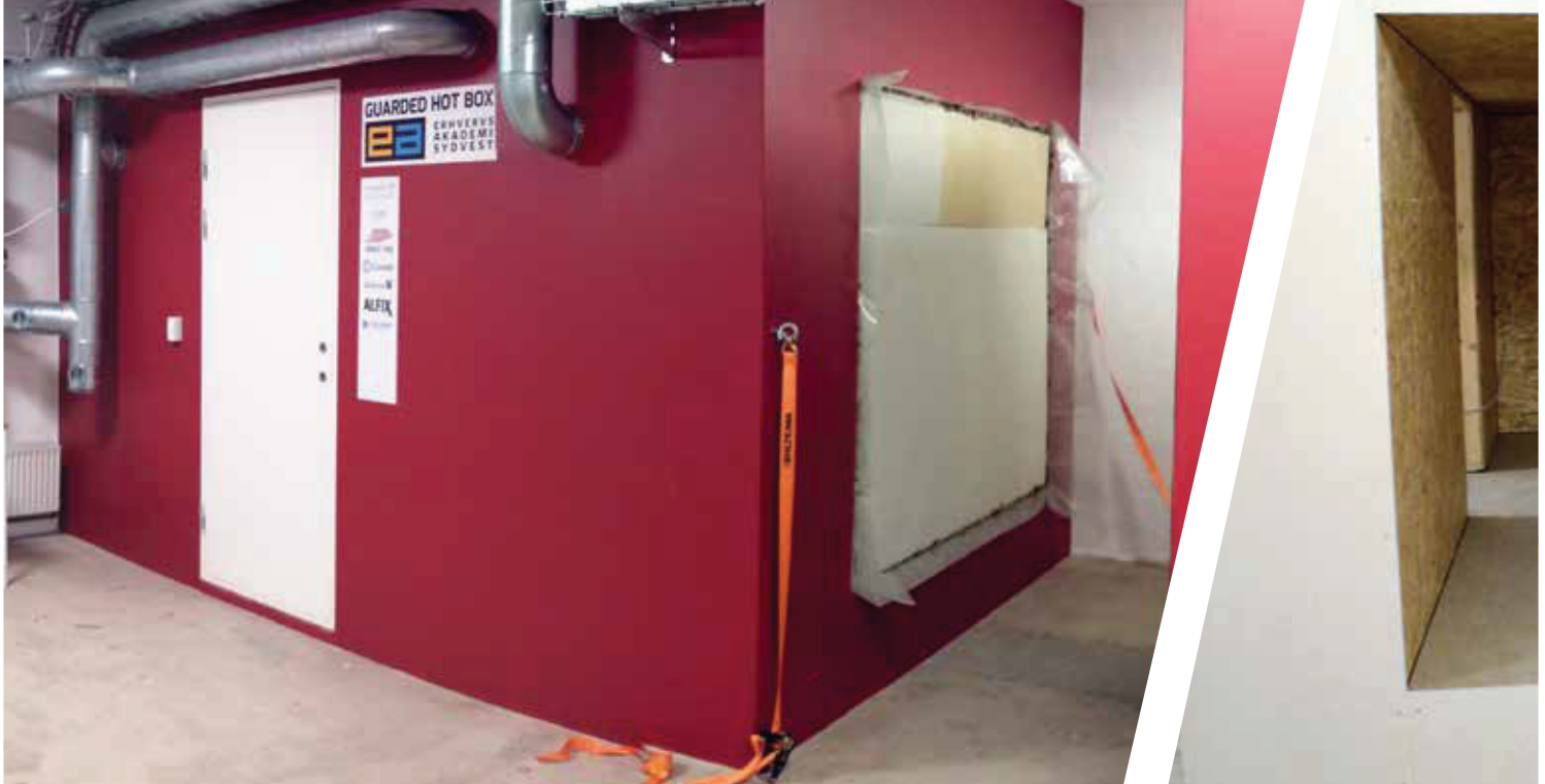
Guaded Hot Box er bygget i fællesskab af lærere og studerende på EASV. Et lignende laboratorium for måling af varmetab i bygningskonstruktioner findes kun et par andre steder i landet. Foto EASV
